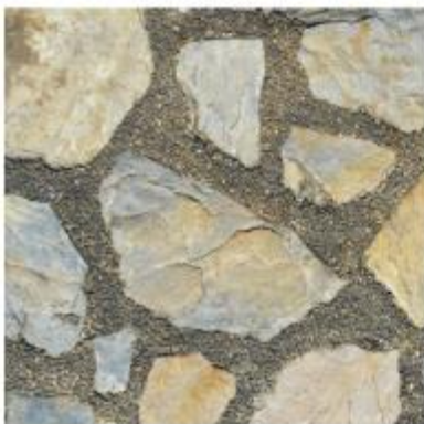
Riferimento - Pavimentazione in massi di pietra su malta di cemento
