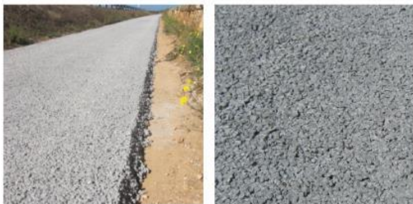
Riferimento - Pavimentazione in cemento drenante
