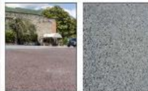
PAV03 Rifacimento marciapiedi in asfalto colato
