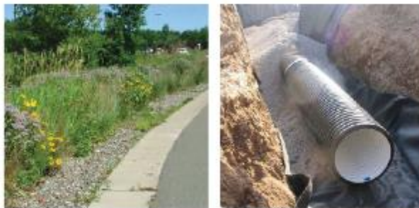
Riferimento- Trincea drenante
