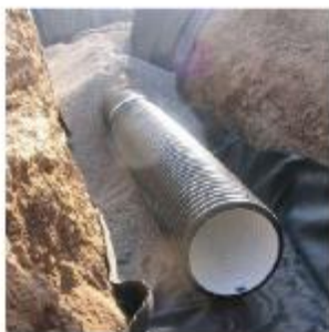
Riferimento- Trincea drenante
