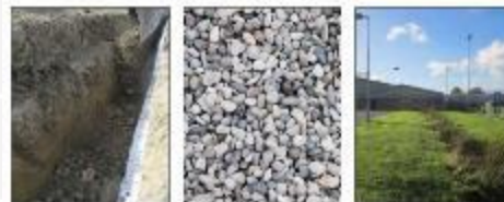
PAV02 Cemento drenante
