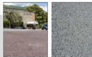
PAV03 Rifacimento marciapiedi in asfalto colato
