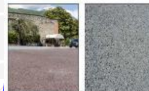
PAV03 Rifacimento marciapiedi in asfalto colato
